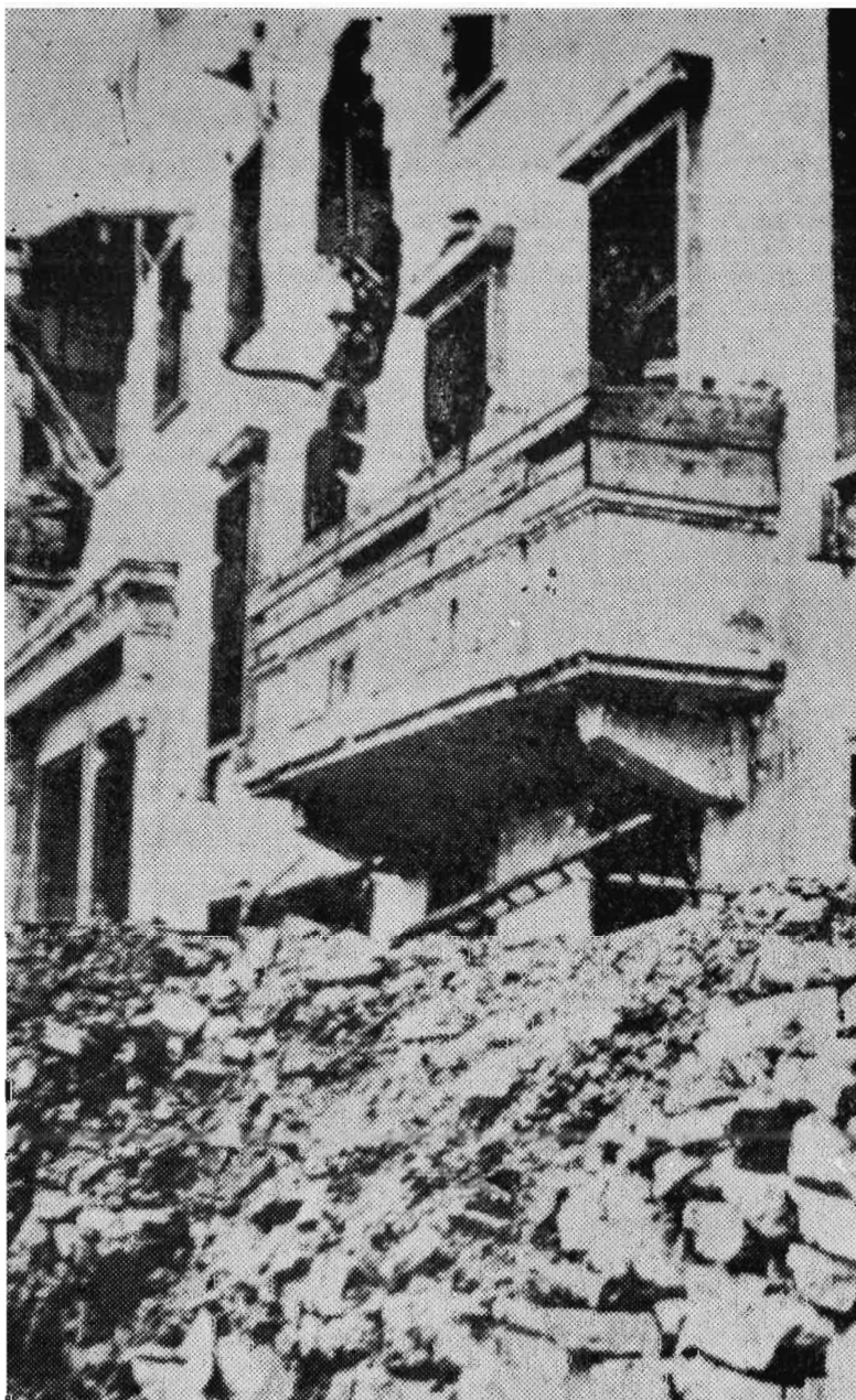
بمباران های پایپی ساختمانها را بصورت وحشتناکی در آورده
