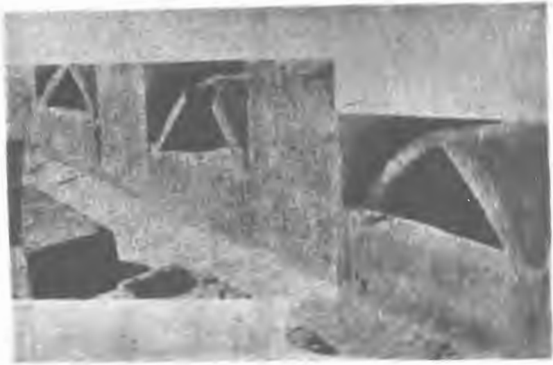
طریقه طاق زدن با گل خام در ساختمان شماره ۳ تپه دهان غلامان
