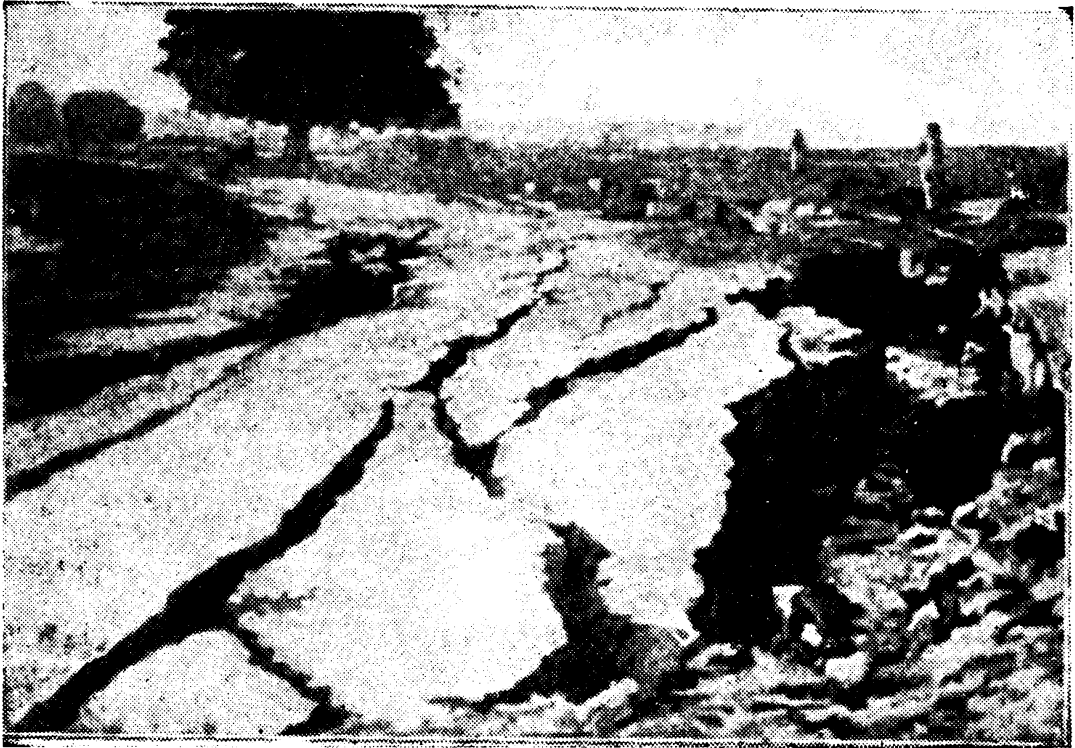
شکل ۴۵ - شکافهایی که بر اثر زلزله به وجود آمده است
