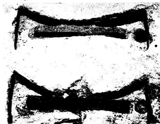
نمونه بسترهای آهنی (گنگو) که برای اتصال سنگها بکار رفته با پوشش سربی روی آن
